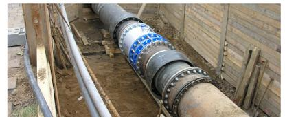
El OPTIFLUX 2300 montado mediante brida con referencia virtual
